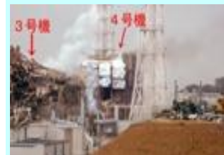
Οι κατεστραμμένοι πυρηνικοί αντιδραστήρες No. 3 και No. 4 του πυρηνικού σταθμού Φουκουσίμα της Ιαπωνίας
